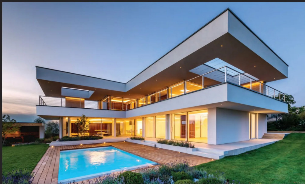
▲ Dvě horizontální desky, které nad sebou na pohled volně levitují a jsou propojeny pouze skleněnými plochami nabízejí otevřené funkční dispozice s minimem vnitřních podpor. Zdálnivá lehkost stavby je vykoupena technicky náročným statickým řešením. Samozřejmostí jsou nejnovější technologie at už co se týká vytápění, chlazení či systém inteligentního řízení, který se stará o bezproblémový chod celého domu.
