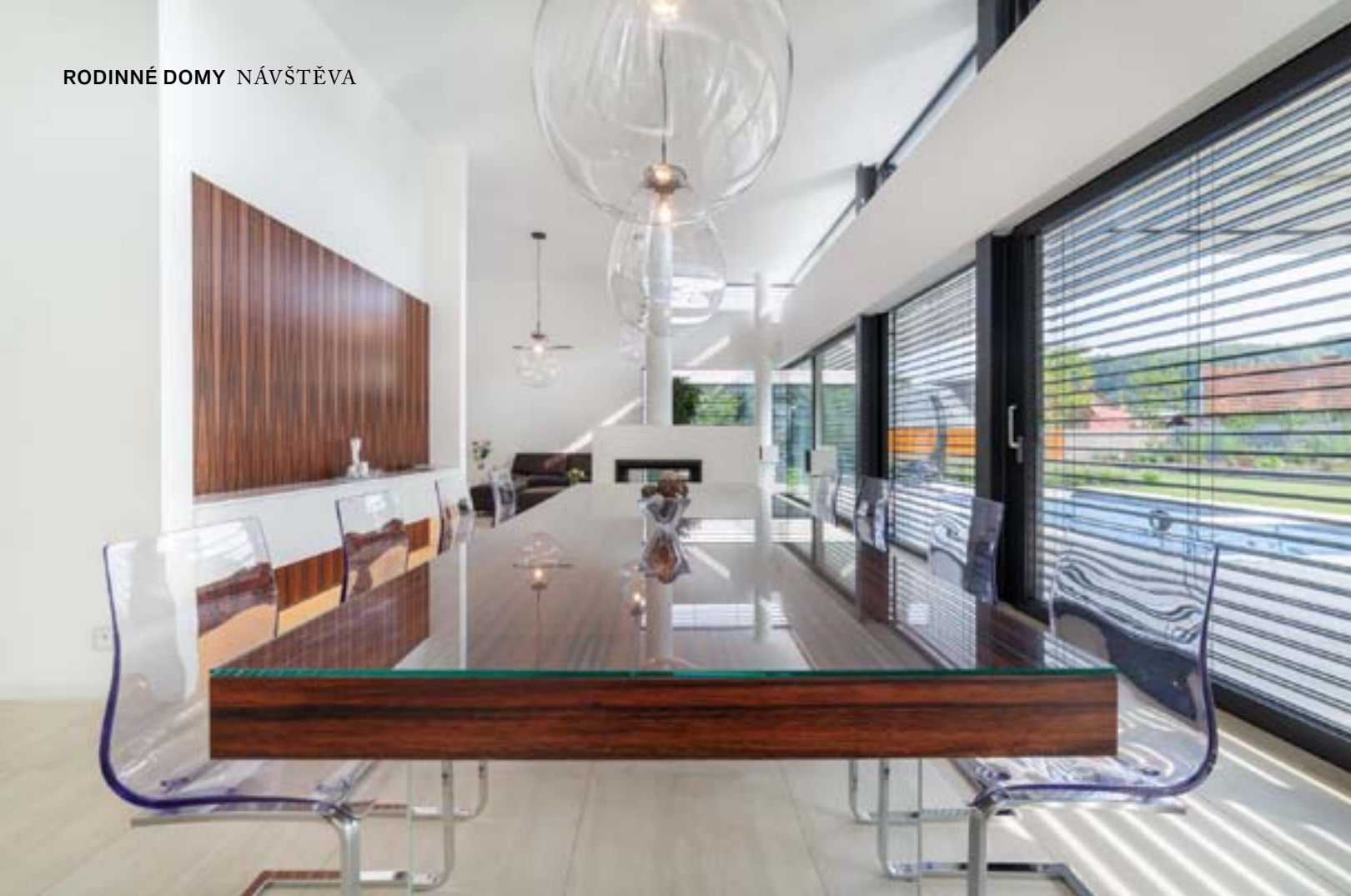
Prosklenou fasádu tvoří střídaně pevně zasklené a posuvné plochy (zdvižně posuvný systém Schüco) o šířce 2,5 metru. Pevné části mají skryté okenní rámy, extrémně dlouhý nadokenní překlad podporují dva subtilní středové sloupky z válcovaných ocelových I profilů
