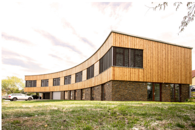
Výstavba nové administrativní budovy – LS Choceň
